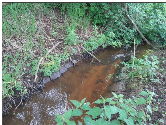
Koryto Řečického potoka je historicky opevněno kamennou dlažbou.
